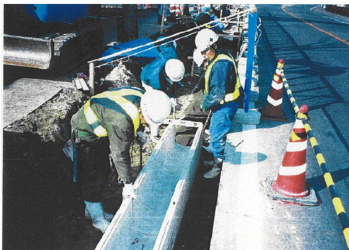
〈側溝の設置〉
