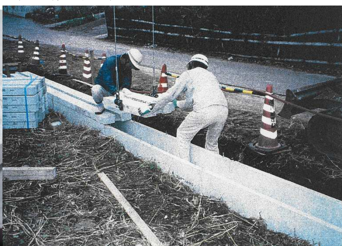
〈蓋の据え付け〉
