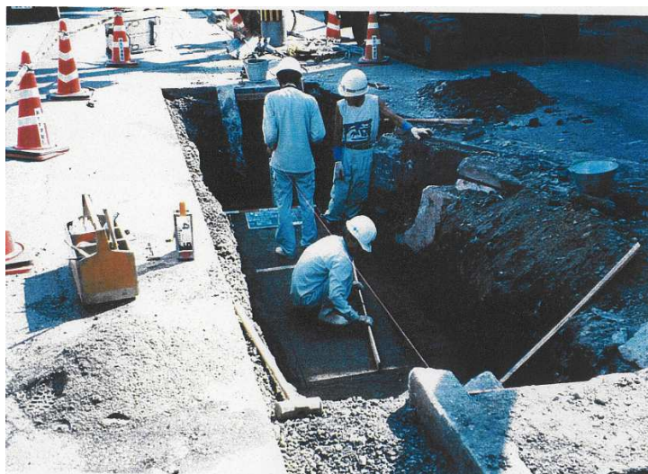
〈敷きモルタル施工〉
