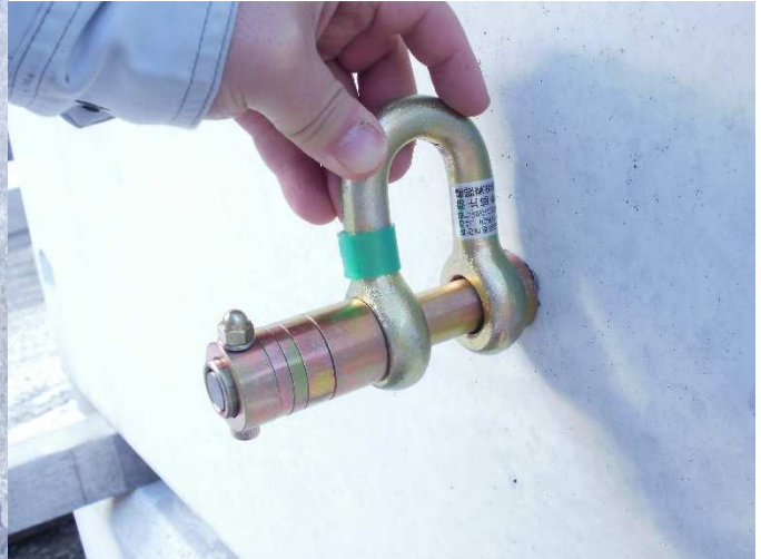
〈吊り金具取り付け〉
